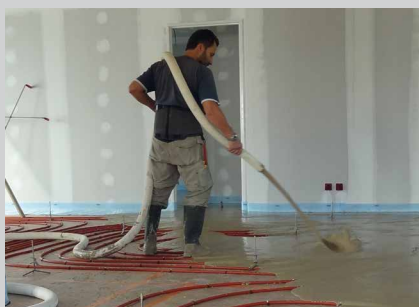
Die genaue Materialdosierung garantiert die Herstellung eines homogenen und qualitativ hochwertigen Fließestrichs.
